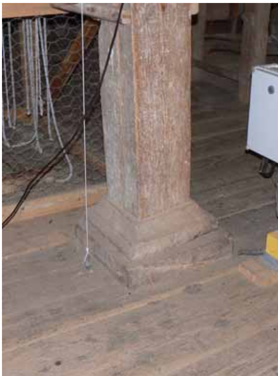
Till vänster: Förskjuten pelare. Till höger: Hussvampsangrepp.
