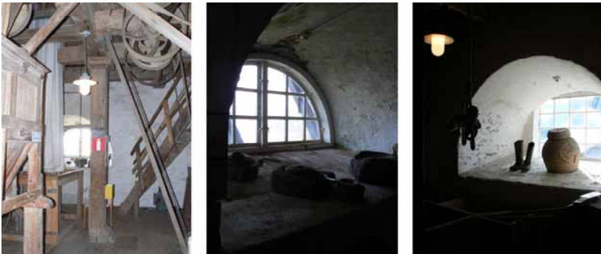
Till vänster: Magasinsloftet (ovanvåningen i foten). Mitten: Lunettfönster. Till höger: Småspröjsat gjutjärnsfönster.
