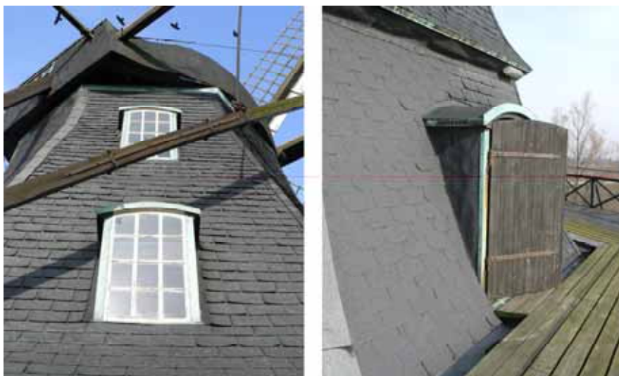
Kvarnkroppen med dess beklädnad i pappshingel.
