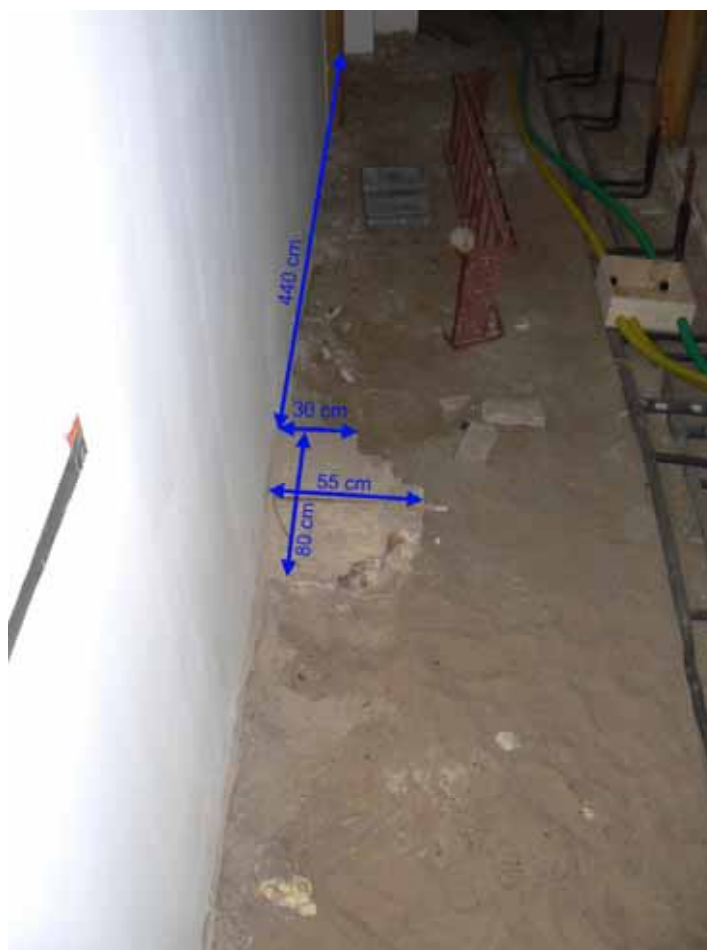
Bild mot väster. Resterna av den rivna valvpilastern belägen mellan södra långhusväggens nuvarande fönsteröppningar.
