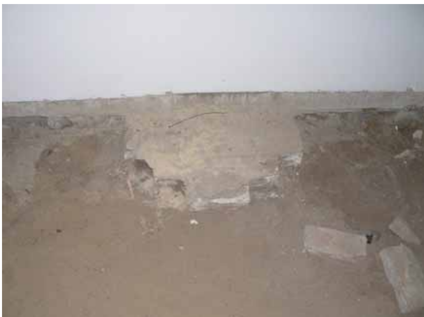
Pilasterfragment mot söder
