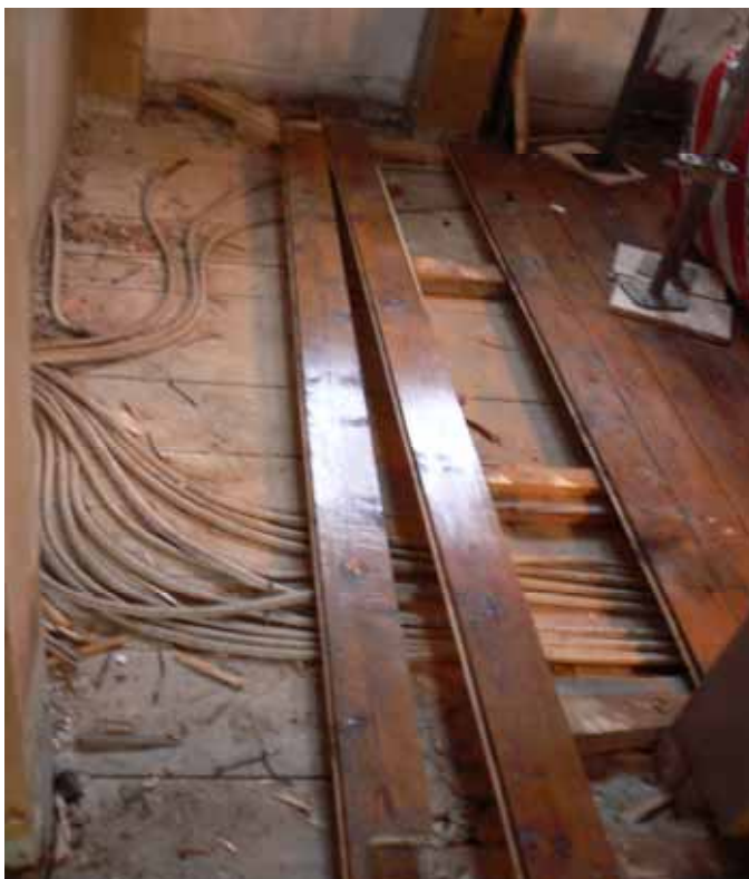
Nykyrkans ursprungliga trägolv från 1822 samt det nu borttagna brunlackerade golvet
