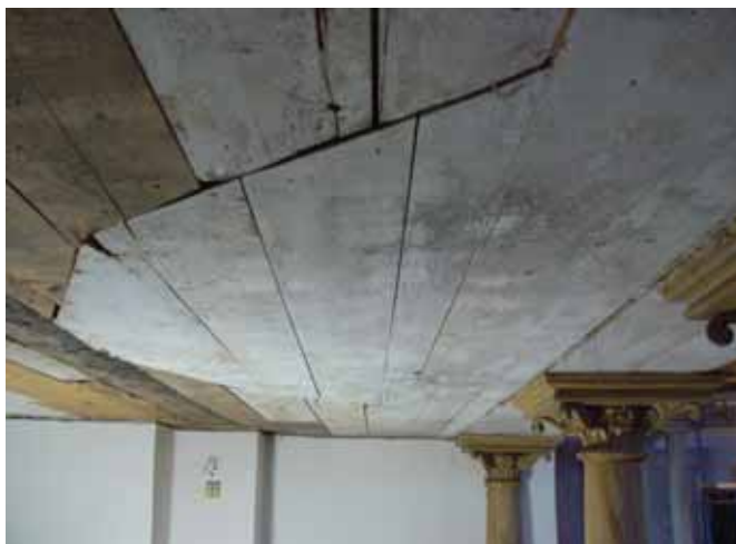
Takbrädor under västra orgelläktaren, efter att väven tagits bort
