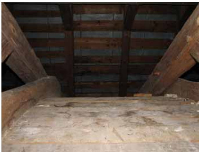
Tunnvalvet över långhusvinden
