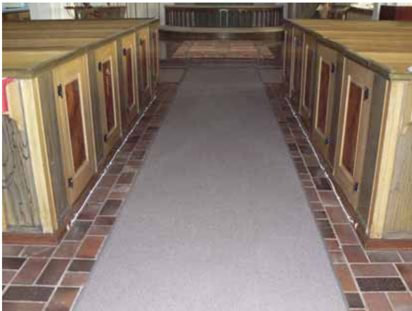
Det nya kablaget till bänkkonvektorerna drogs utanpå bänkinredningens befintliga socklar.
