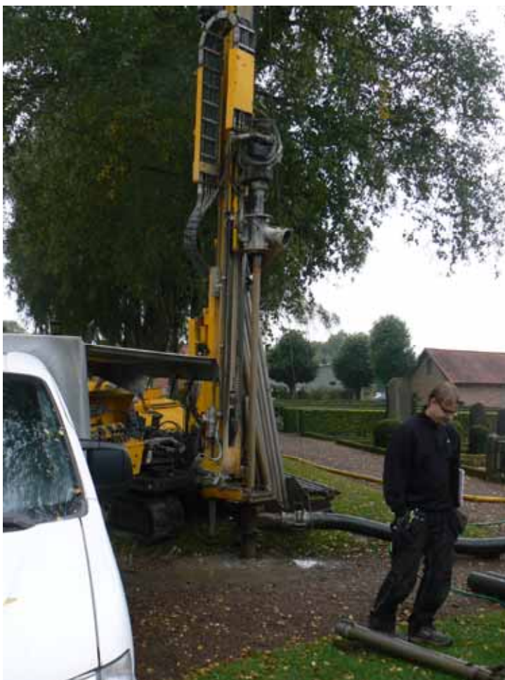
Ett av de tre borrhålen som borrades upp för bergvärme på kyrkogården, strax norr om den norra korsarmen.
