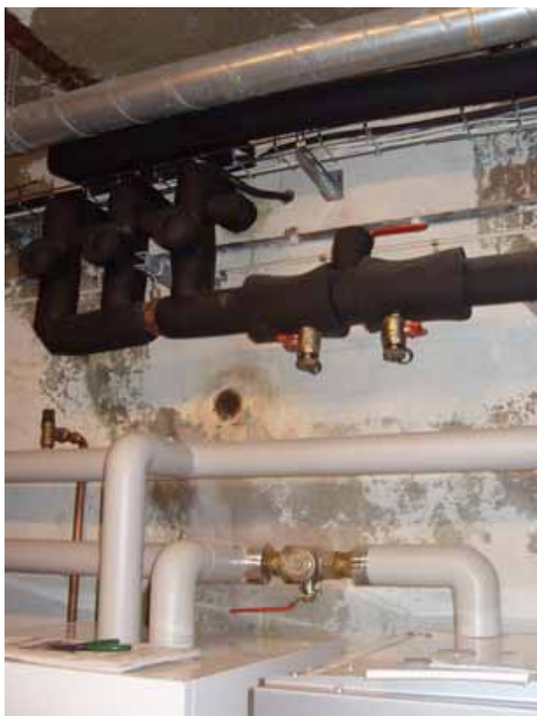
Hål för kollektorslangarnas genomföring i muren under mark.
