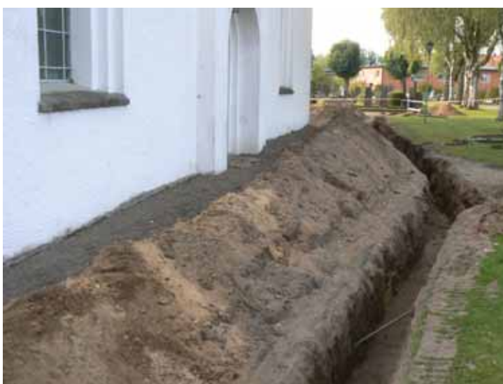
Nedgrävning av isolerade slangar till ett frostfritt djup om ca 60-70 cm.
