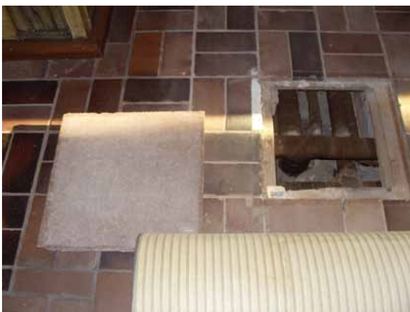
Befintlig kulvert i mittgången, vari nytt kablage förlades.
