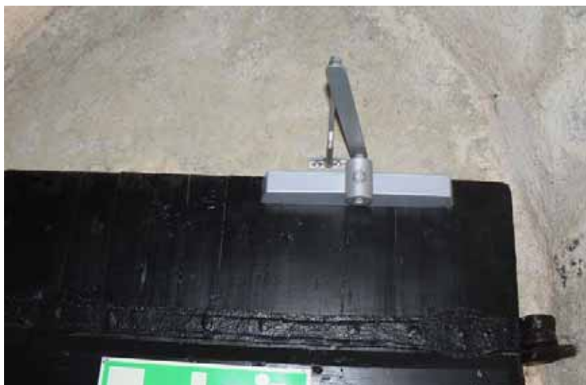
Kyrkportens utseende efter renovering och montering av nytt lås och dörrstängare.
