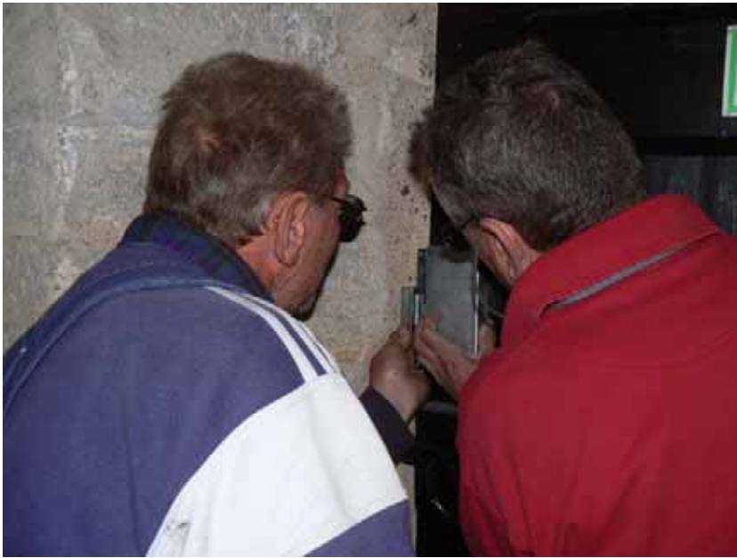
Det moderna låsets bricka monteras i portalens fog.
