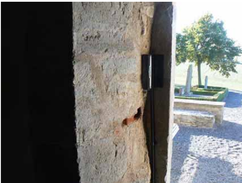
Det färdiga resultatet med låsbleck och kabeldragning i smygen.
