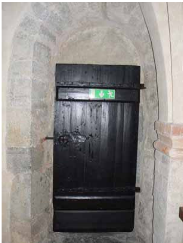
Kyrkportens utseende efter renoveringen men före det moderna låsets montering, invändigt.
