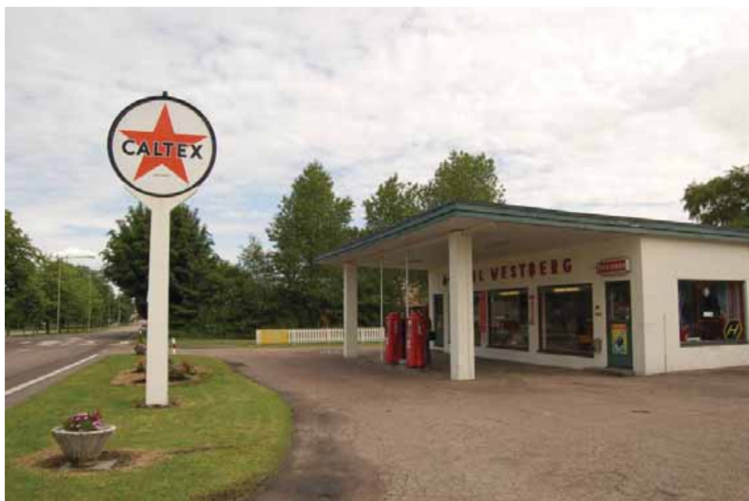
Bensinstationen mot norr.
