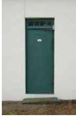
Bilden till vänster: Toalettdörren med spröjsat överljus. Bilden till höger: Ett av verkstadsfönstren.
