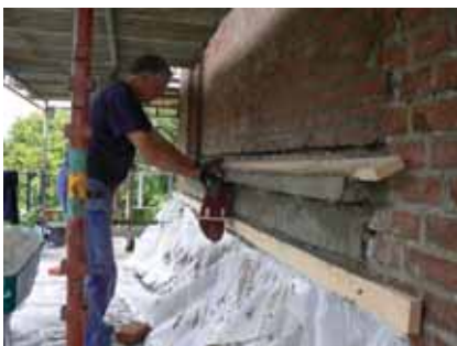
Arbete med nya listdragningar som ersatte skadade utsmyckningar
