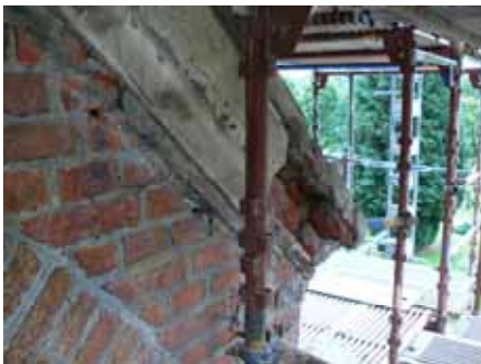
Exempel på skadade cementtillverkade byggnadsdelar
