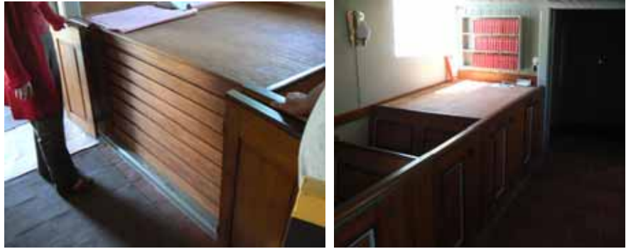
Överst t.v. Omlagt tegelgolv för tidigare sättningskada. T.h. Ny kabeldragning på långhusvinden. Nederst t.h. Nytt textilskåp för liggande förvaring i långhusets sydvästra del. T.h. Förvaringsutrymme i långhusets nordvästra del.
