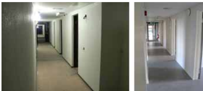
Korridor på tredje våningen före och efter ombyggnaden (rum 323).
