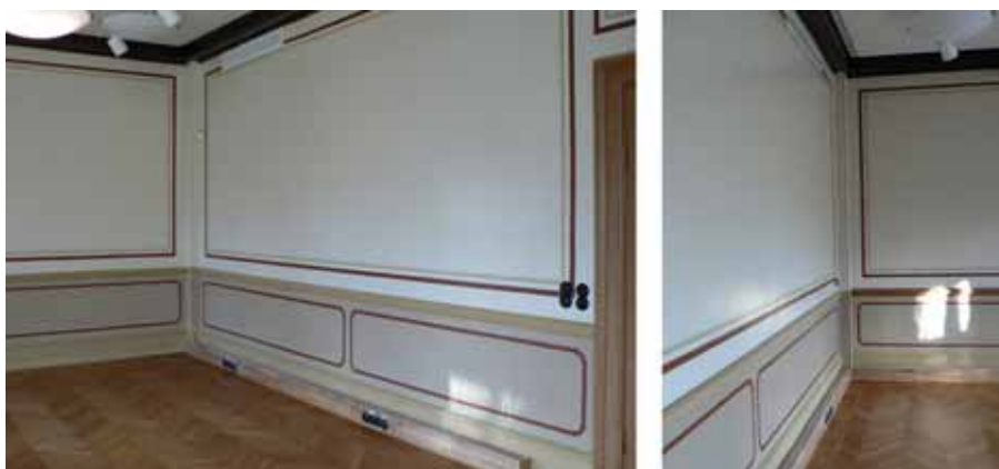
Rum 216 efter ombyggnad. Vid fototillfället var målning av snickerier inte färdig.
