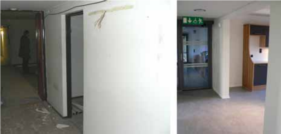
En större öppning har tagits upp i en reverterad trävägg till ett pausrum på tredje våningen (rum 353).
