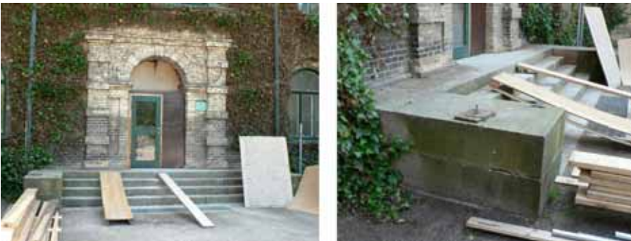
Entrén under ombyggnaden. Entrédörren är nedmonterad för att byggas om så att den uppfyller kraven på tillgänglighet.
