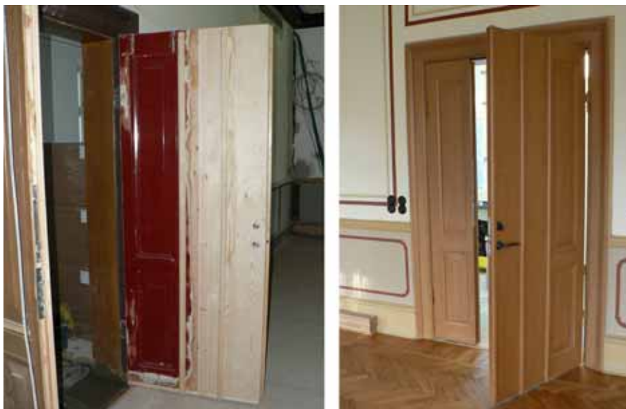
Pardörr till rum 216. Under ombyggnad samt efter färdigställandet.
