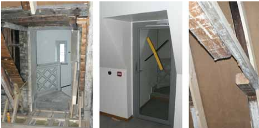
Rum 340. Dörr till spiraltrappa under samt efter ombyggnaden. Kapad takbjälke.
