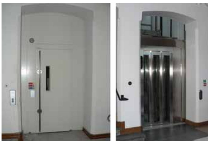
Hissen före och efter ombyggnaden (rum 114).
