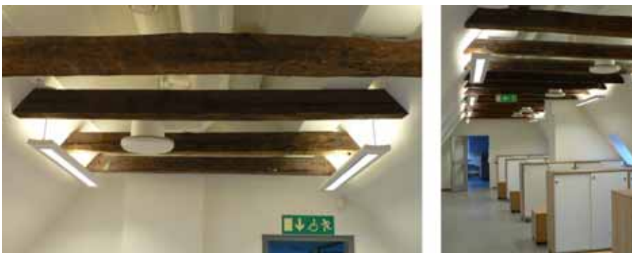
Rum 340. Den kapade takbjälken ersattes med en hel bjälke.
