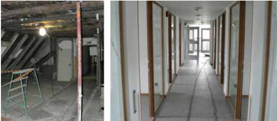
Fjärde våningen under rivningsarbetet samt i ombyggnadens slutskede (rum 410).
