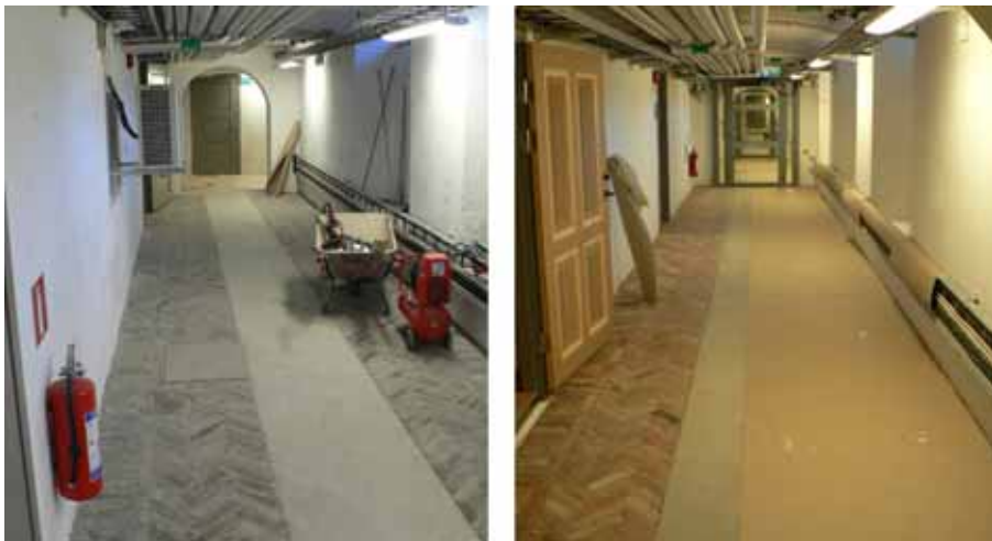
Tegelgolvet i källaren efter ombyggnaden. Till vänster det ursprungliga teglet i rum 023. Till höger det nya, rödare teglet i rum 025.
