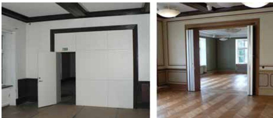
Öppningen mellan rum 216 och 214 före och efter ombyggnaden.
