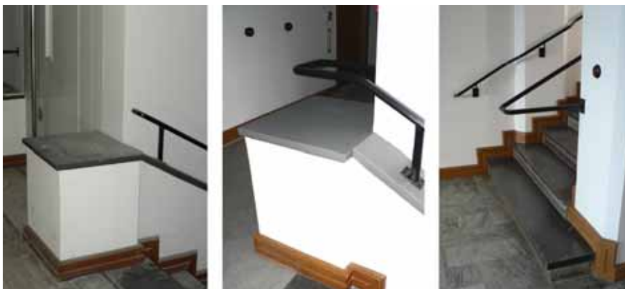
Till vänster och i mitten: Ledstänger på fjärde våningen (417), före och efter ombyggnaden. Till höger ledstänger på andra våningen (218) efter ombyggnaden.
